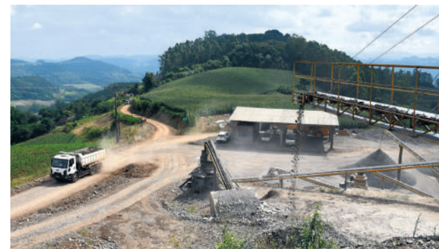
Britagem Majolo está localizada em Capitão
