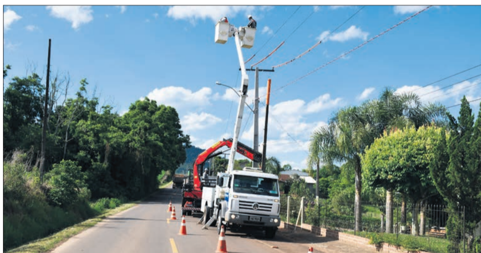
Ao final da obra, estarão instalados 75 postes
