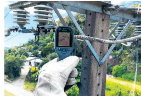
Aparelho detecta o aumento da temperatura dos componentes da infraestrutura das redes elétricas
