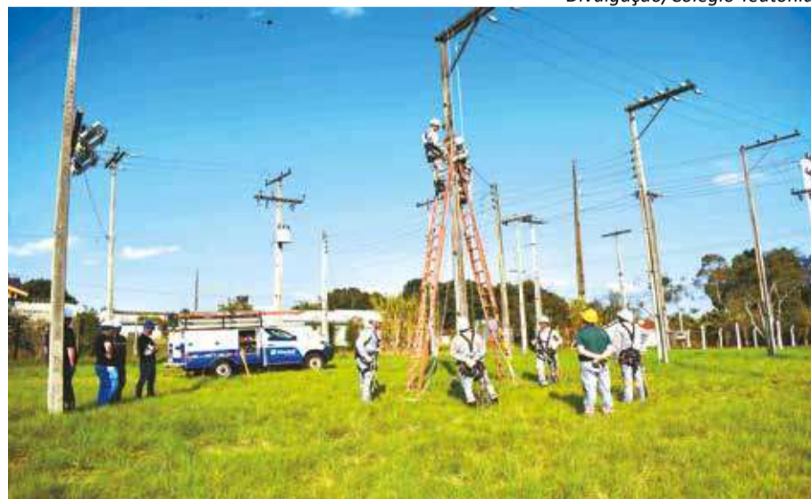
Aulas práticas ocorrem no pátio de treinamento aberto e abrigado
