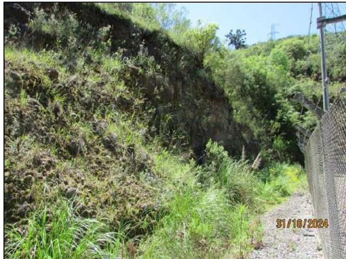
Figura 21. Talude a Norte com quedas de pequenos blocos não apresenta nenhum ponto que necessite de atenção especial em relação a uma queda maior de blocos.
