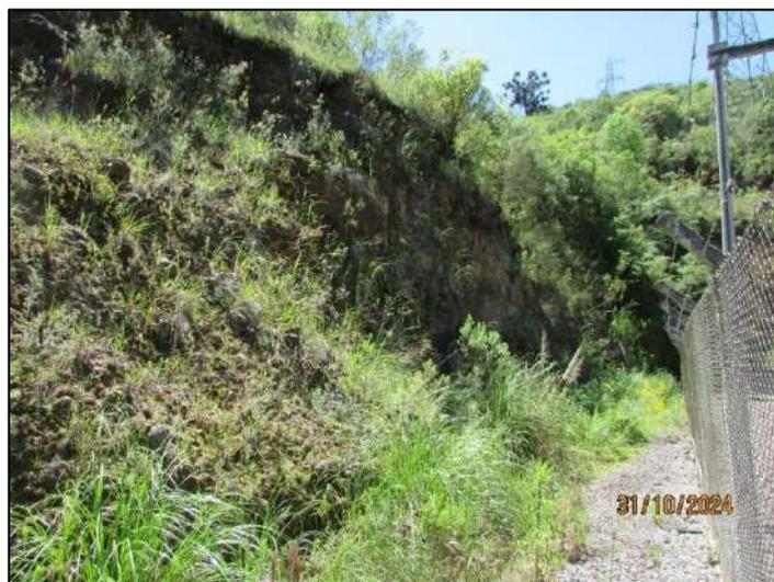
Figura 22. Talude de enrocamento a Sul da subestação está com vegetação se desenvolvendo em sua face sem que as raízes movam os blocos.
