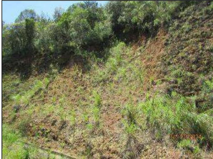
Figura 10. Na porção do talude que sofreu queda de material foi realizado o plantio, a vegetação não se desenvolveu plenamente mas, as quedas de volume de solo cessaram momentaneamente.
