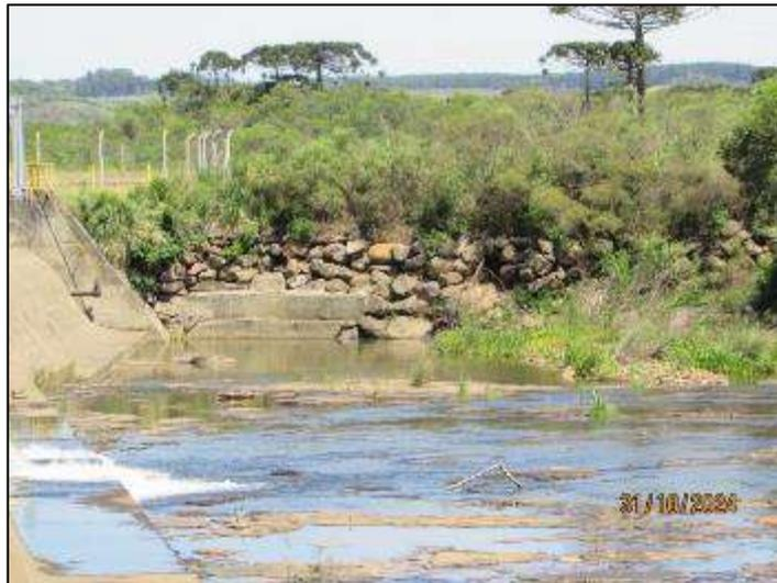
Figura 37. Enrocamento na margem esquerda do barramento estável.
