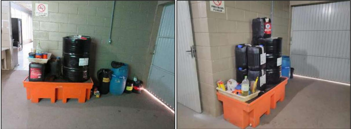
Figura 6. Armazenamento de óleo lubrificante e resíduos perigosos em pallet contentor.
