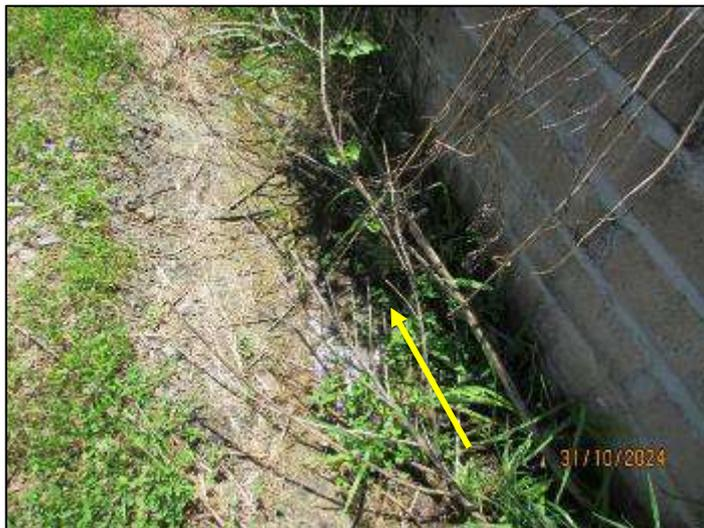
Figura 20. Base do muro com escoamento de água para Norte indicado pela seta.
