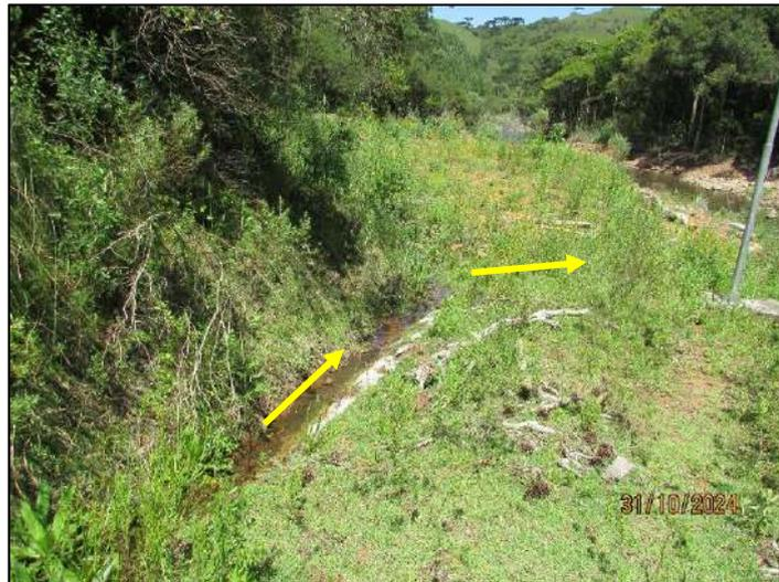
Figura 25. Pontos de escoamento de água identificados pelas setas.
