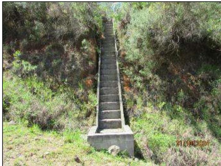
Figura 15. Escadaria de dissipação de energia de água na face do talude.
