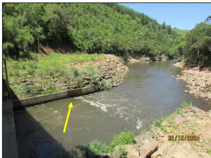
Figura 24. Área de aterro ao lado do canal de fuga com seta mostrando local do escoamento de água constante após as intensas precipitações de 2023 e 2024.
