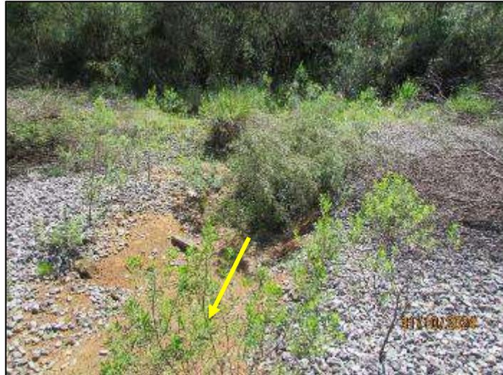
Figura 32. Único local que necessita acompanhamento na margem direita próximo a ombreira é um canal de escoamento de água indicado pela seta mostrando o sentido do fluxo.
