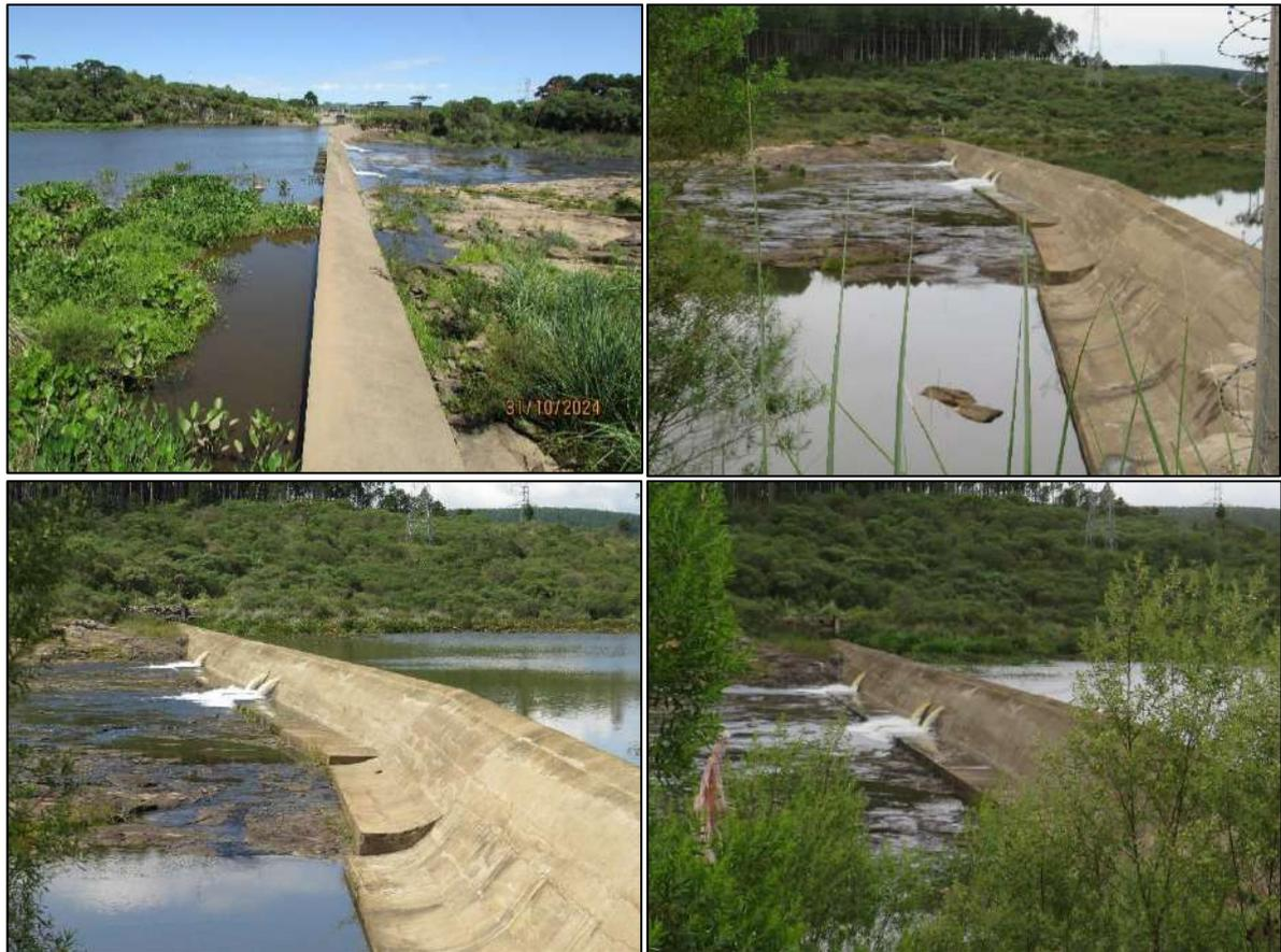
Figura 2. Dispositivos de manutenção da vazão remanescente existentes no corpo da barragem, em pleno funcionamento, verificados durante o ano de 2023.
