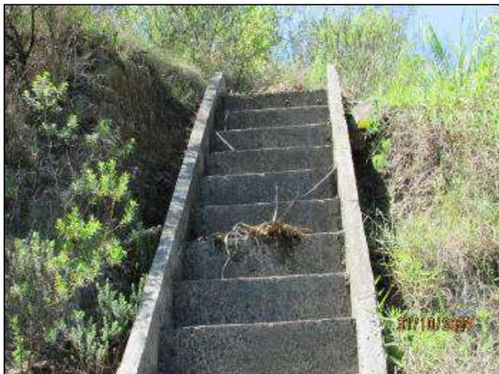
Figura 11. Escadaria de dissipação de energia de água pluvial está com suas laterais perdendo o solo com a lixiviação lenta, mas ainda não oferece risco de avaria na estrutura.
