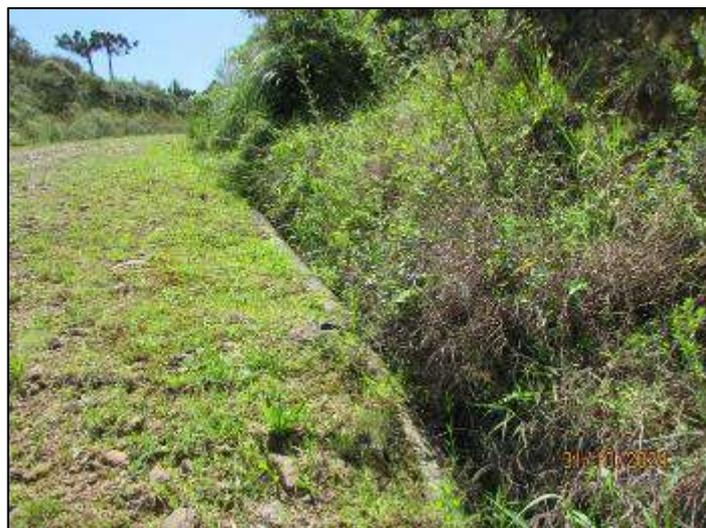
Figura 16. Canaletas de escoamento de água necessitam de uma limpeza.
