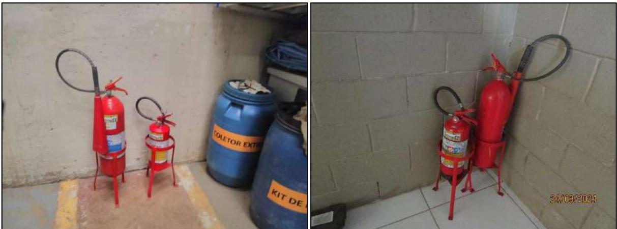
Figura 7. Extintores de incêndio, mantidos no interior da casa de força.
