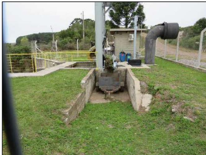
Figura 111. Resíduos do limpa grades, armazenado temporariamente em um reboque, para posterior destinação.
