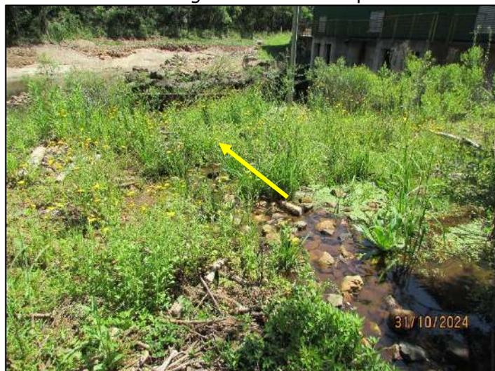
Figura 26. Pequeno curso d'água que está se formando sobre área de aterro ao lado do canal de fuga onde o fluxo leva direto para o canal. Seta indica o sentido do escoamento.
