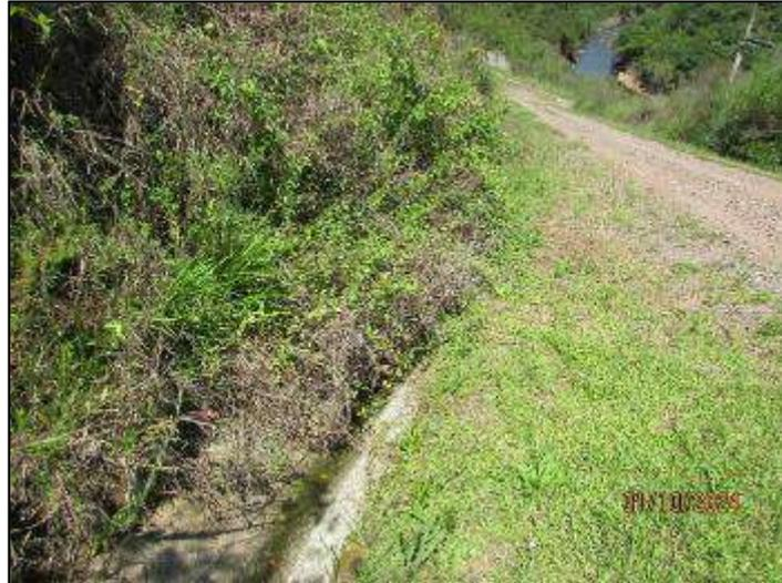
Figura 17. Vegetação rasteira da face do talude do acesso à casa de força está se espalhando pelo interior da canaleta de escoamento de água.
