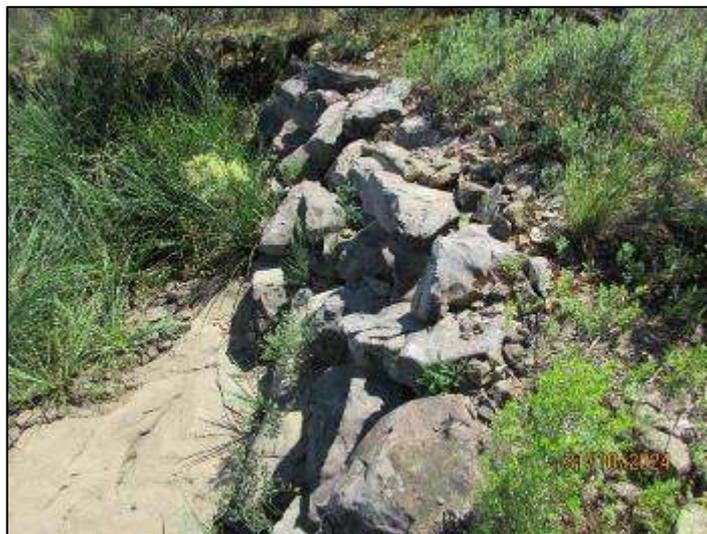
Figura 38. Enrocamento na margem direita após a obreira também está estável.
