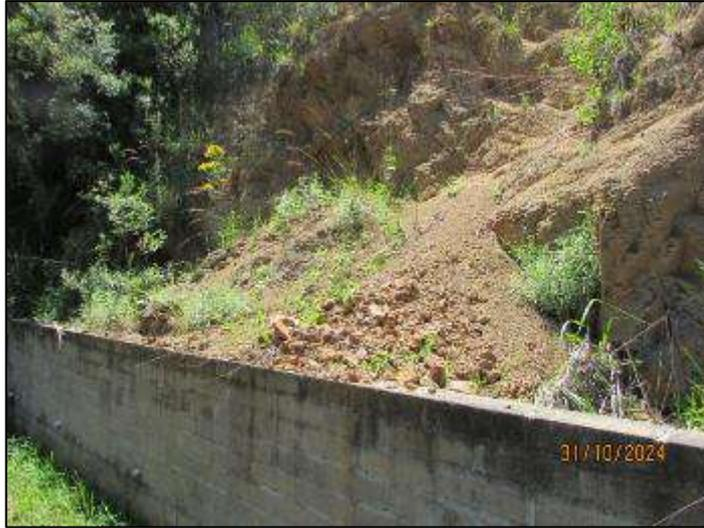
Figura 19. Muro que retém queda de material do talude Leste da subestação está desempenhando a sua função satisfatoriamente.
