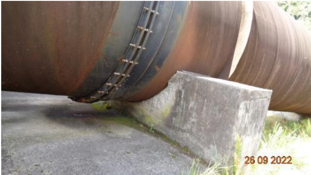
Figura 82 – Blerços em boas condições
