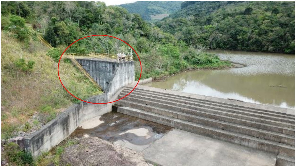
Figura 29 – Barragem margem direita
