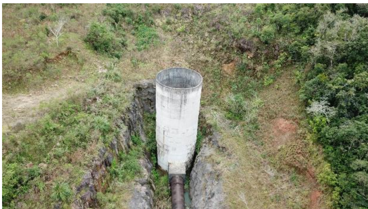
Figura 70 – Vista geral da Chaminé de Equilíbrio
