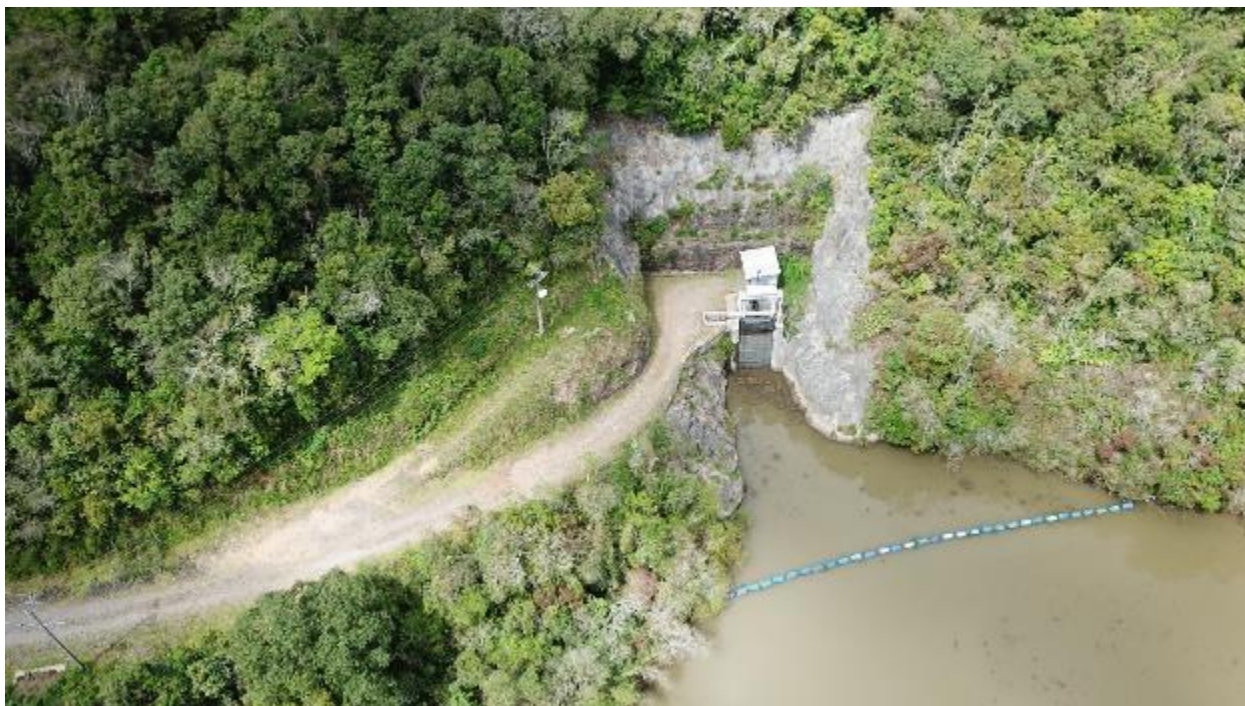
Figura 63 – Vista superior da tomada
