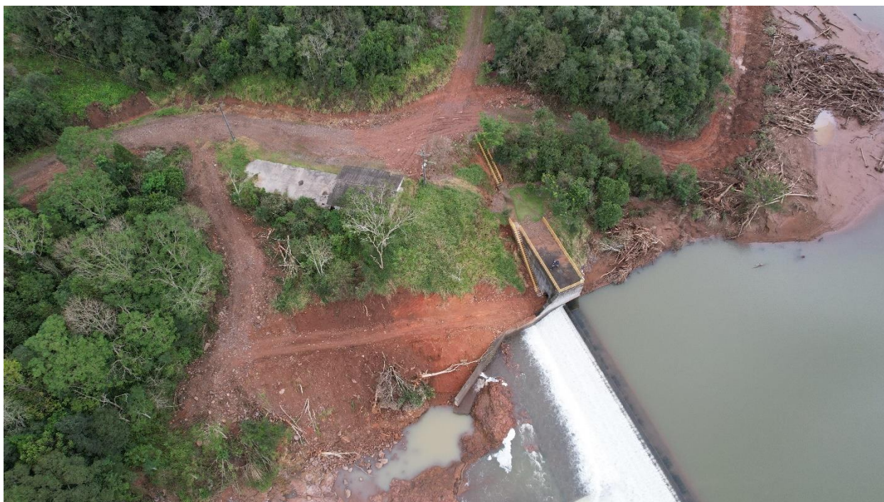
Figura 24 – Crista da Barragem margem direita
