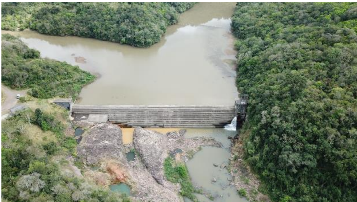
Figura 29 – Vista geral do Vertedouro (ISR 2022)
