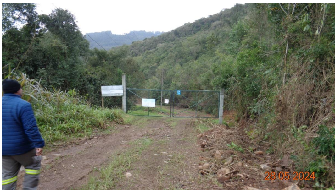
Figura 18 – Acesso para a barragem com cerca e portão
