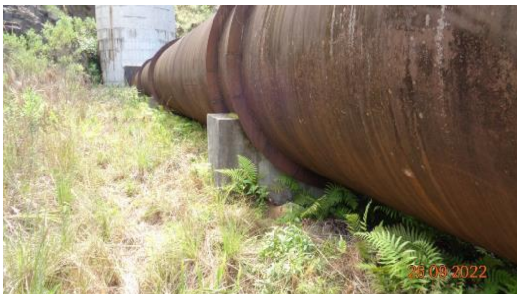
Figura 80 – Berços de apoio e bloco ancoragem
