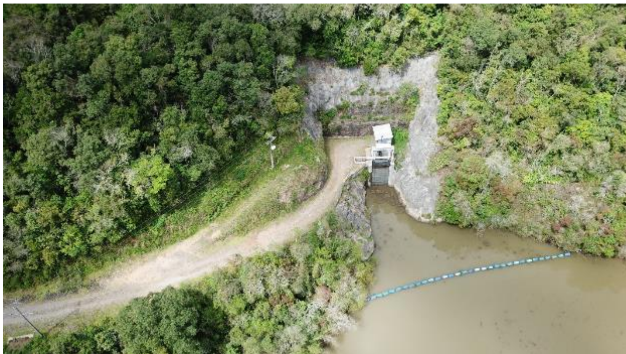
Figura 34 – Vista superior da tomada de água (ISR 2022)
