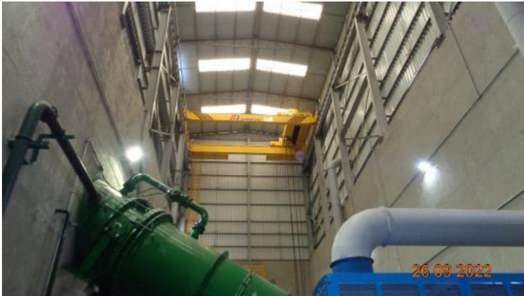
Figura 103 – Telhado e ponte rolante em boas condições
