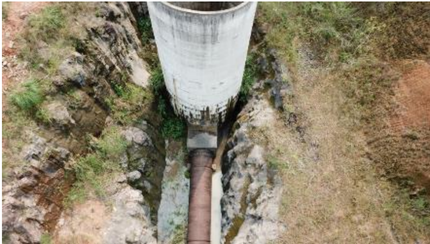
Figura 71 – Chaminé de Equilíbrio (Insp. 2020)
