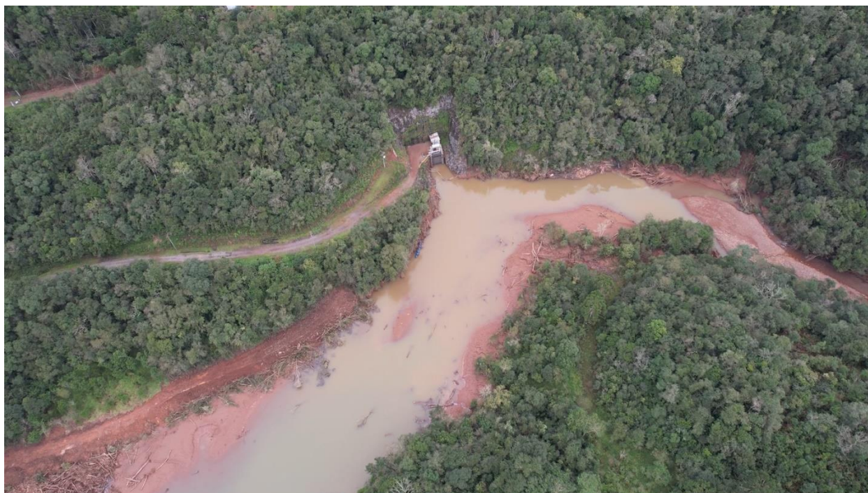
Figura 35 – Vista da tomada de água (ISE 2024)
