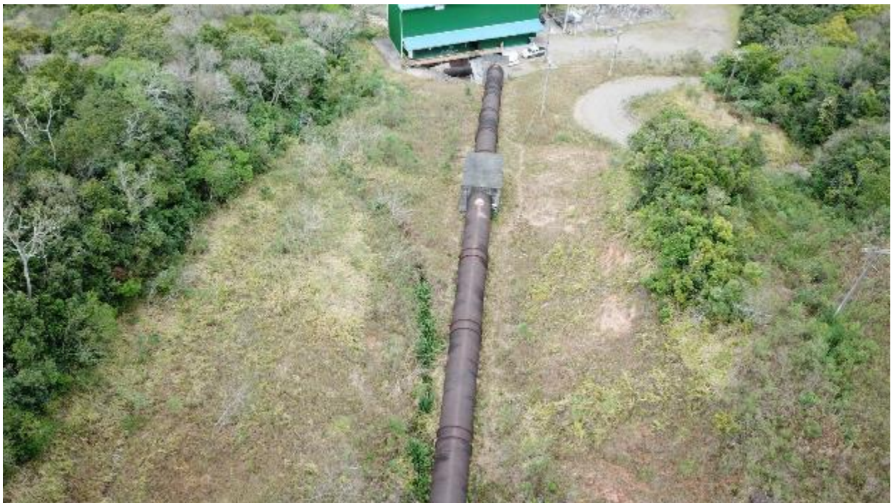
Figura 78 – Trecho final e bifurcação na entrada da Casa de Força
