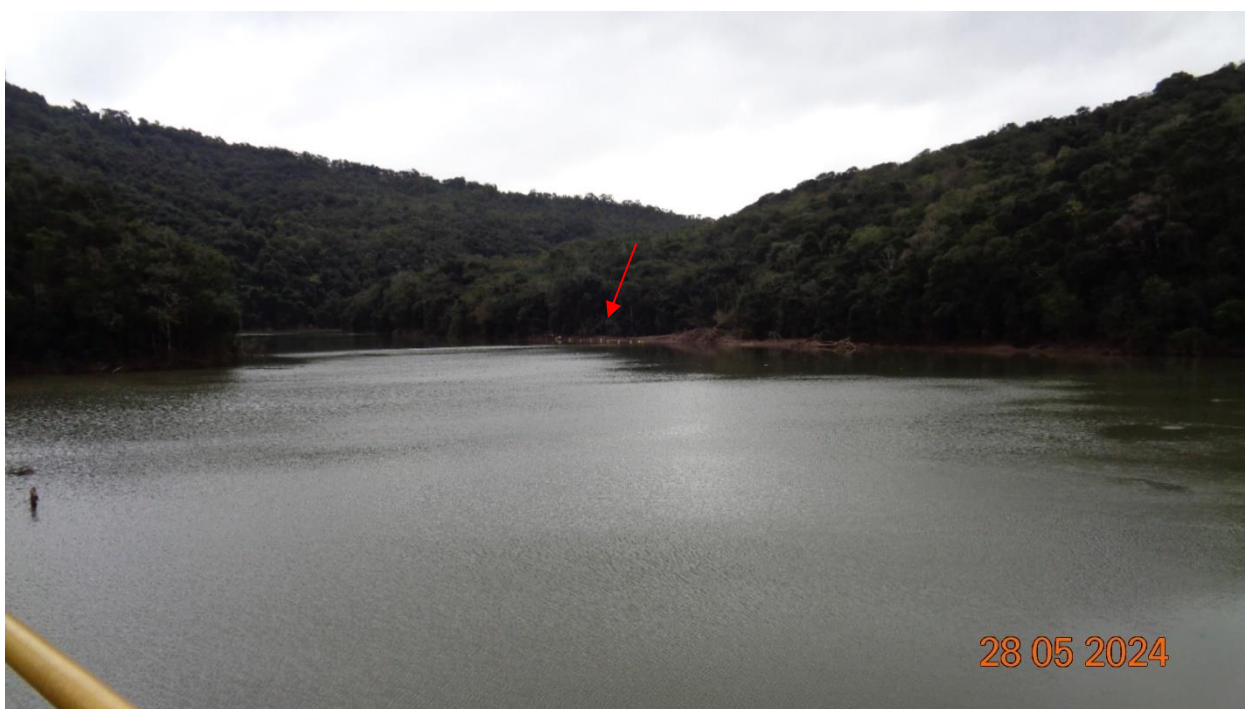
Figura 21 – Detalhe das Boias sinalizadoras com cabo rompido
