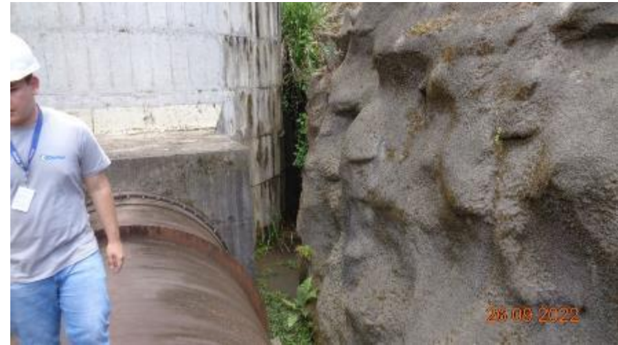
Figura 76 – Detalhe do concreto da Chaminé de Equilíbrio (Insp. 2022)
