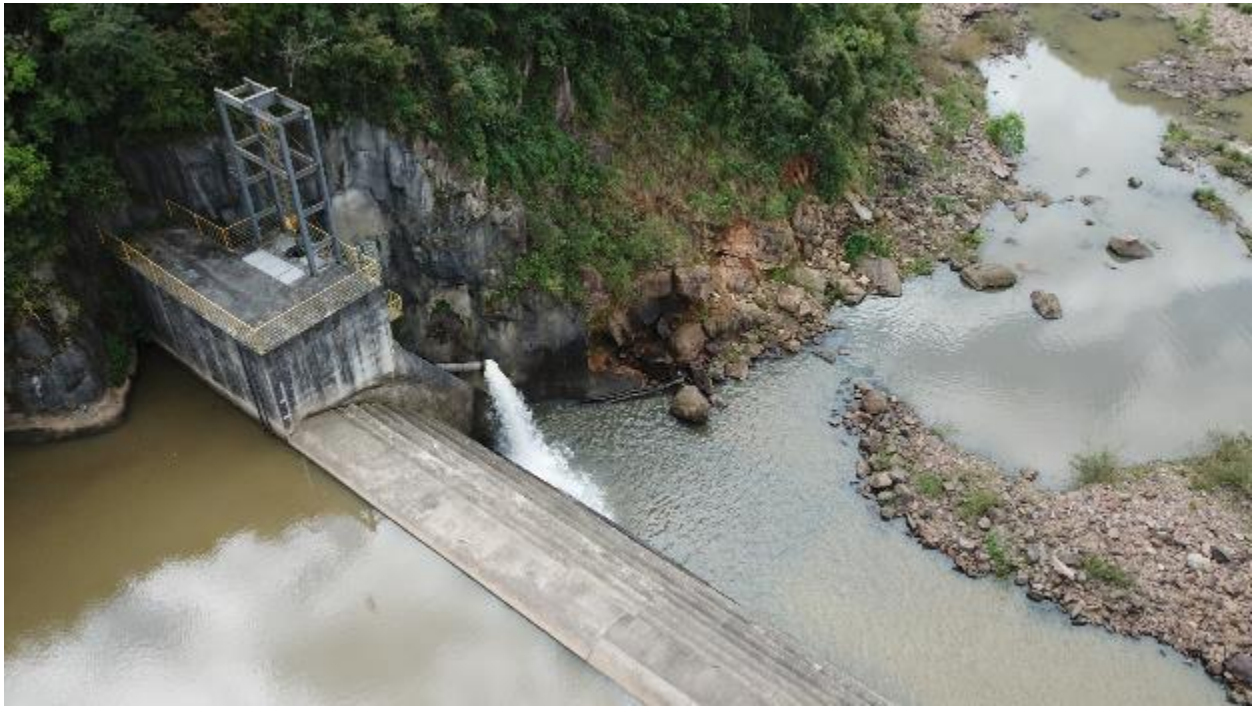
Figura 35 – Vista geral da barragem margem esquerda em boas condições
