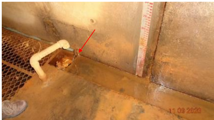
Figura 18 – Medidor de vazão dentro galeria, identificar e melhorar régua leitura (Insp. 2020)
