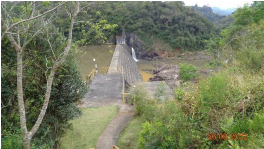
Figura 31 – Crista da Barragem margem direita
