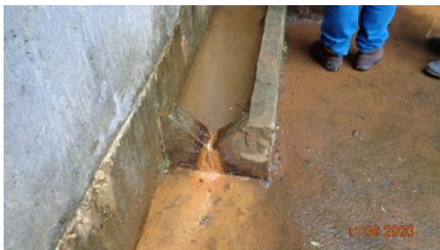
Figura 20 – Medidor de vazão ombreira esquerda, identificar (Insp. 2020)
