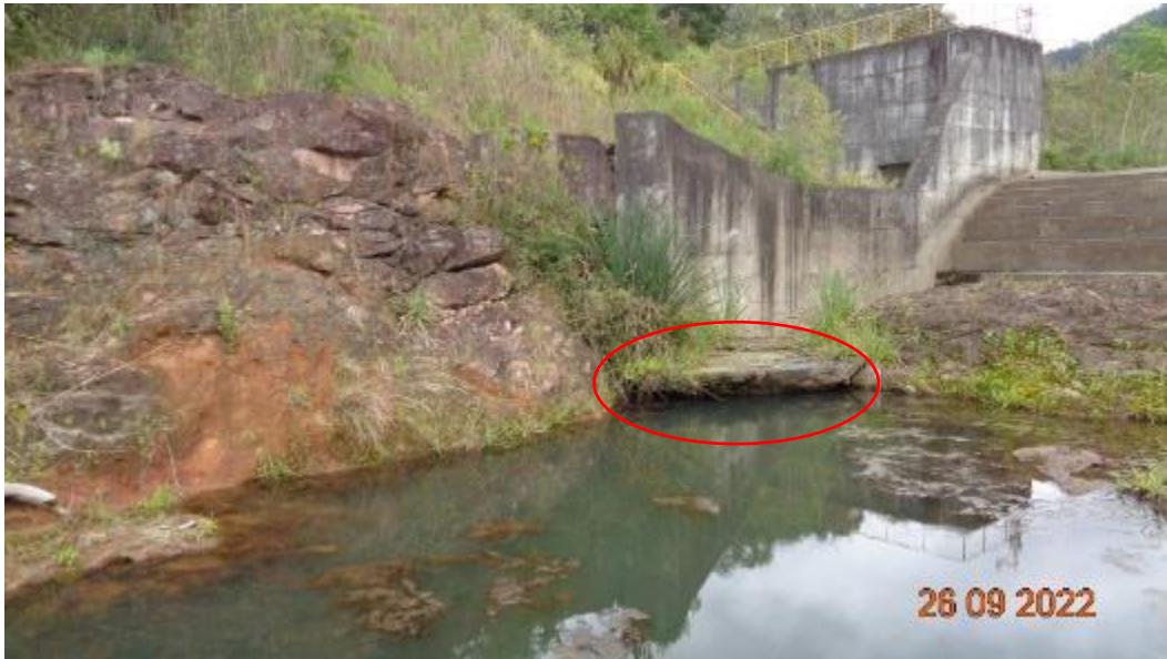
Figura 51 – Realizar concreto dental para dar base ao muro de concreto
