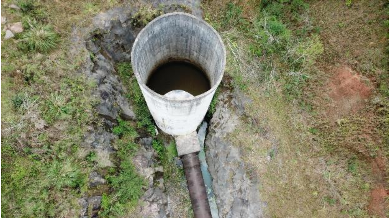
Figura 77 – Trecho inicial após a chaminé de equilíbrio
