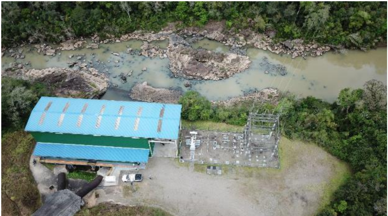
Figura 85 – Vista Geral da Casa de Força
