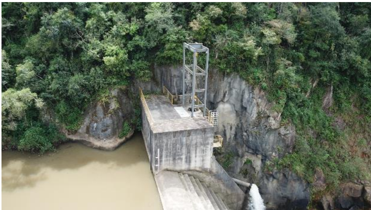
Figura 33 – Crista e talha da descarga de fundo em boas condições
