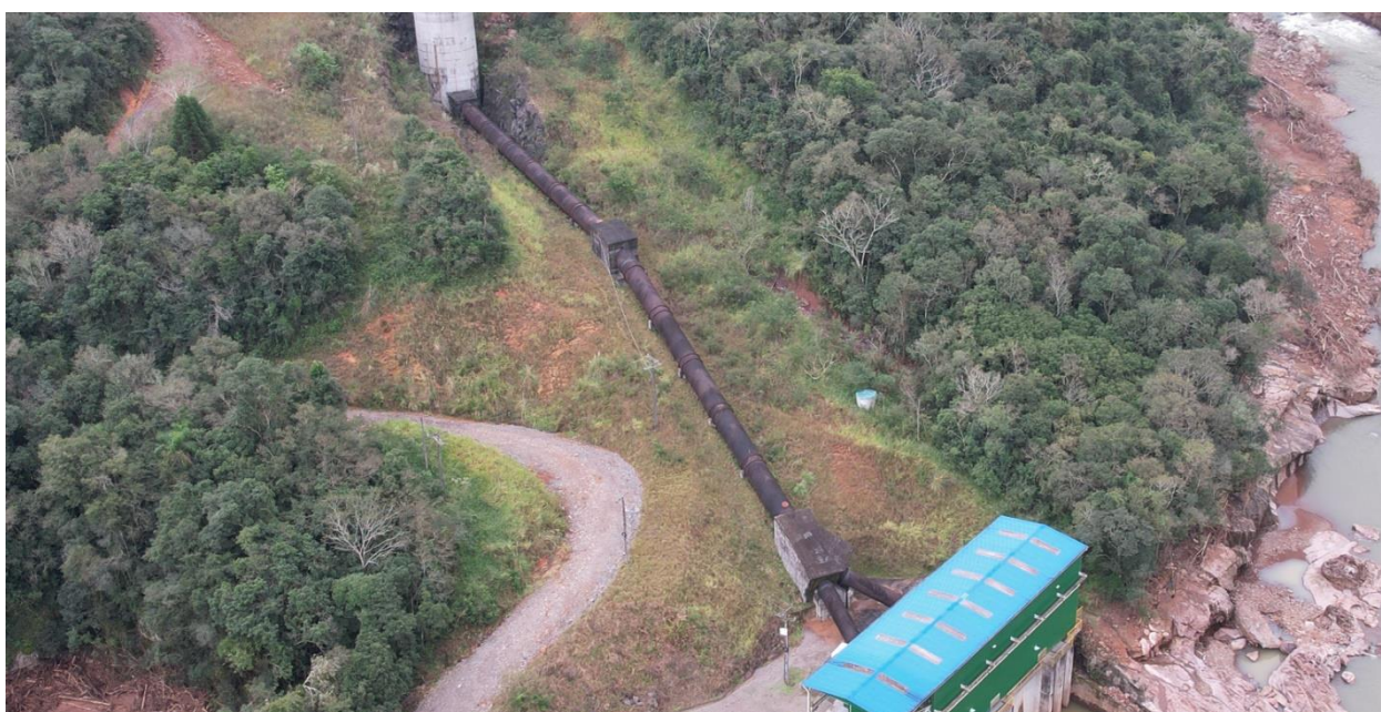
Figura 42 – Conduto forçado (ISE 2024)
