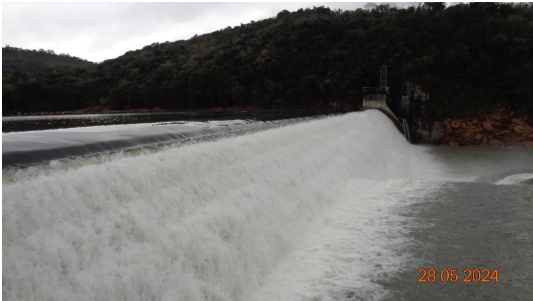
Figura 31 – Perfil do vertedouro com vertimento
