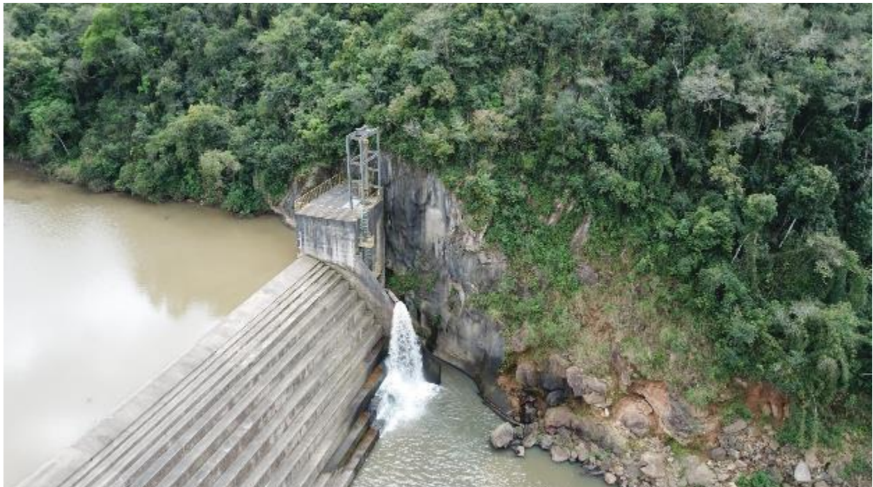
Figura 32 – Jusante da barragem margem esquerda com descarga de fundo
