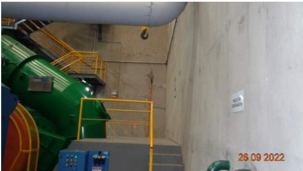
Figura 94 – Paredes boas condições
