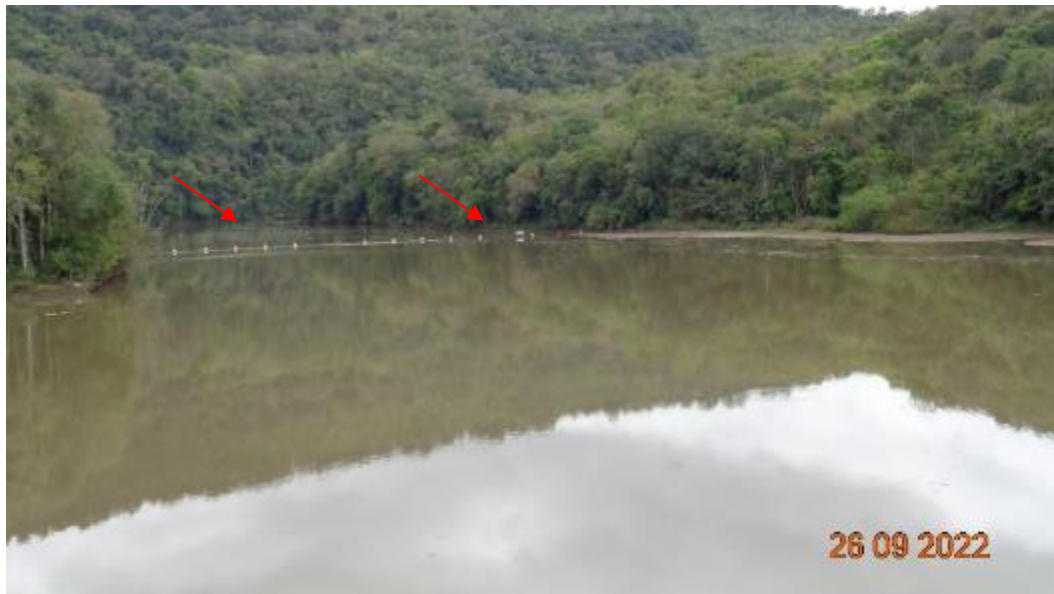
Figura 27 – Detalhe das Boias sinalizadoras do reservatório
