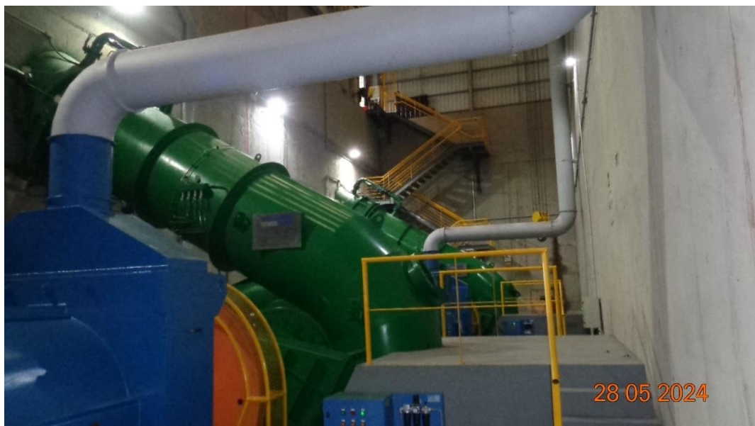
Figura 52 – Parede de jusante sem infiltrações
