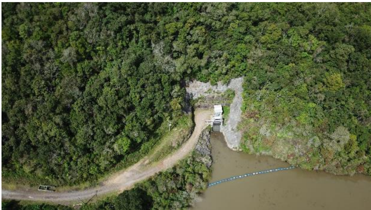
Figura 25 – Acesso a Tomada d'água
