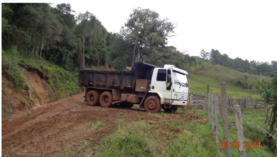
Figura 19 – Manutenção nos acessos externos
