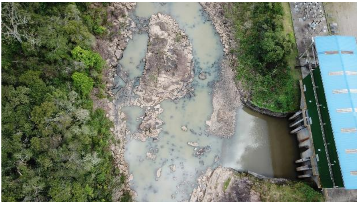
Figura 105 – Vista geral do canal de fuga e material depositado
