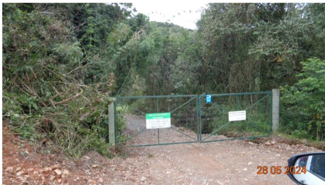
Figura 17 – Portão de acesso a casa de força em bom estado
