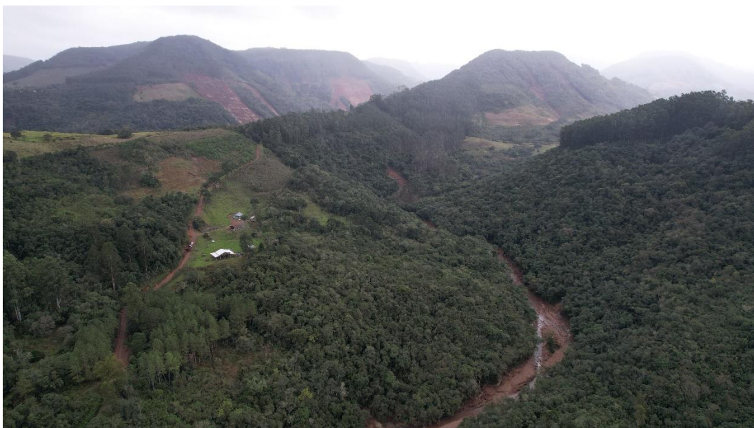
Figura 16 – Vista geral da região com diversos escorregamentos de encostas bloqueando acessos
