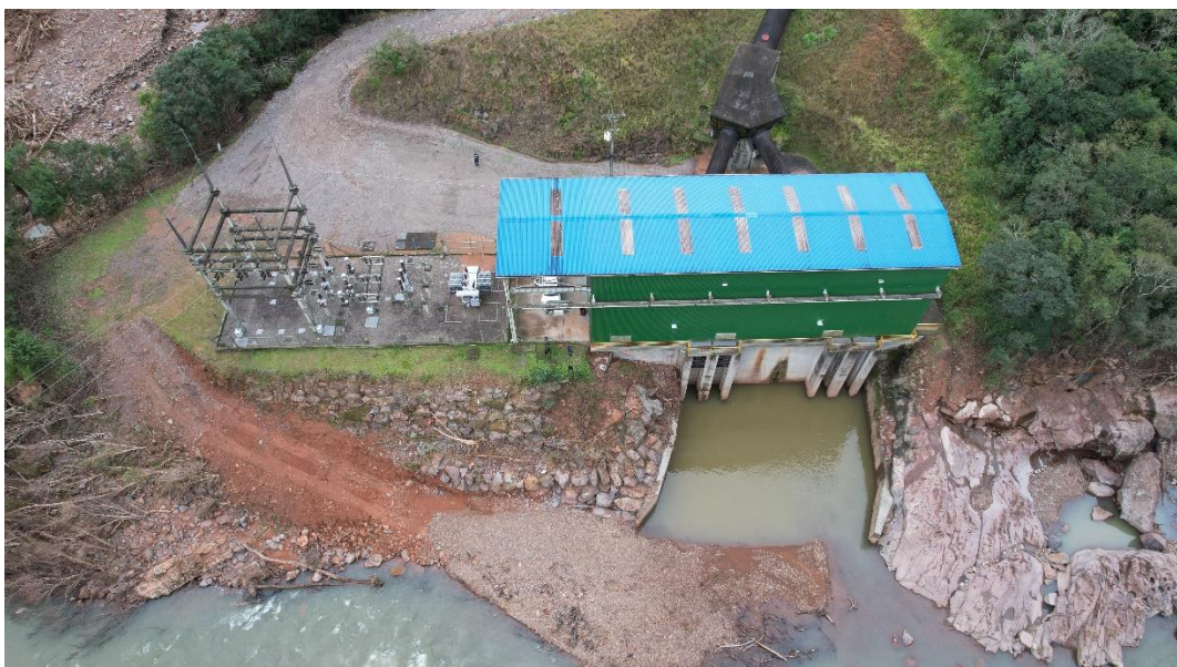
Figura 45 – Pátio da casa de força e subestação (ISE 2024)
