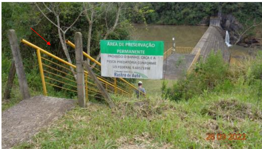
Figura 30 – Crista e escada de acesso a Barragem margem direita
