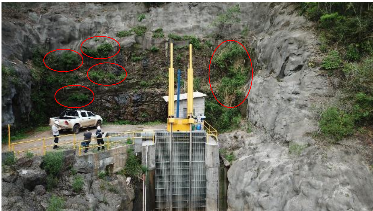
Figura 67 – Talude de jusante da tomada com vegetação (Insp. 2020)
