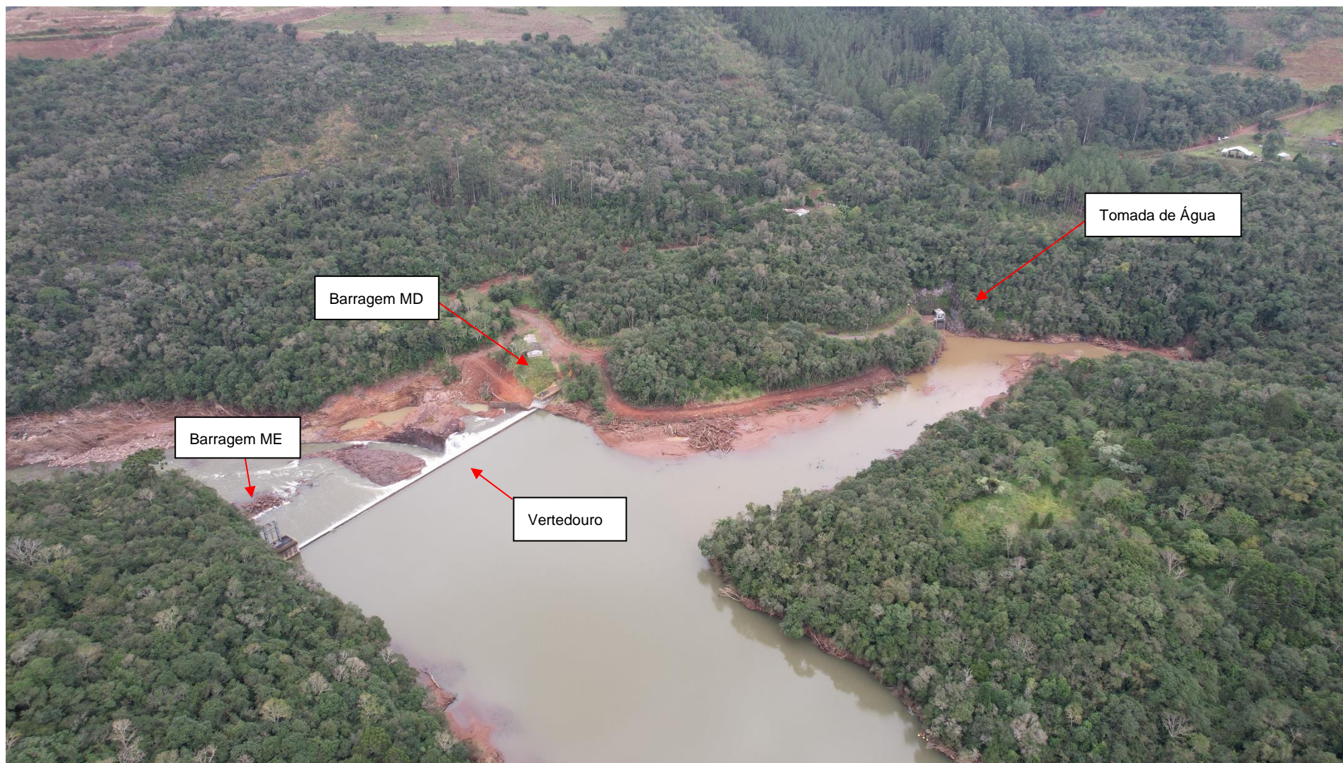
Figura 4 – Estruturas do Barramento da PCH Rastro de Auto
