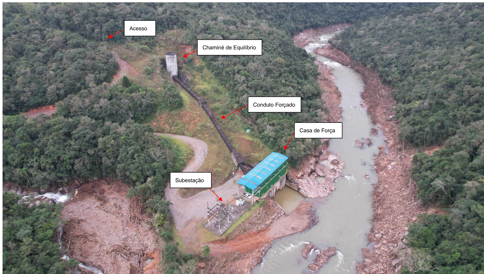
Figura 5 – Jusante da PCH RASTRO DE AUTO
