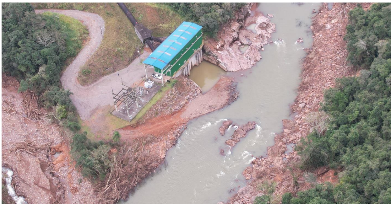
Figura 55 – Vista geral do canal de fuga e material depositado
