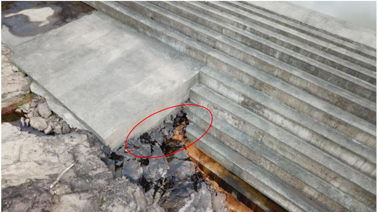
Figura 49 – Ponto a ser tratado com concreto
