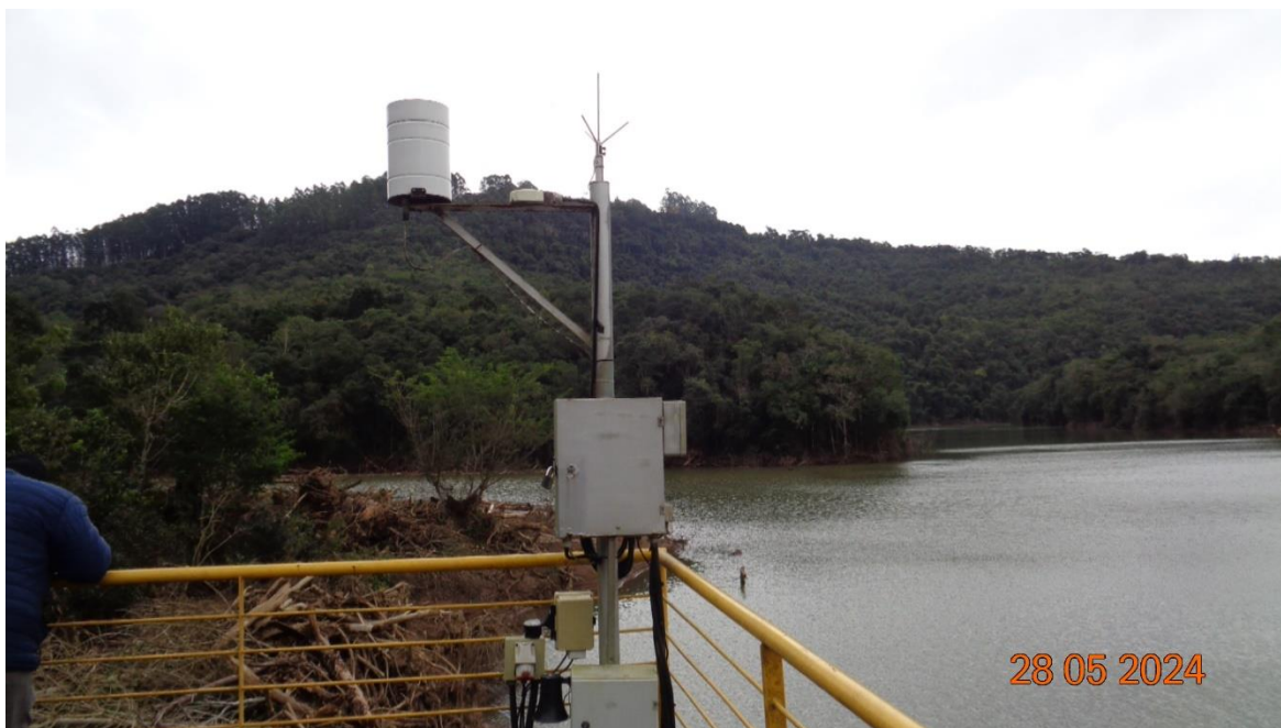
Figura 22 – Estação hidrométrica instalada na Barragem e muito material depositado
