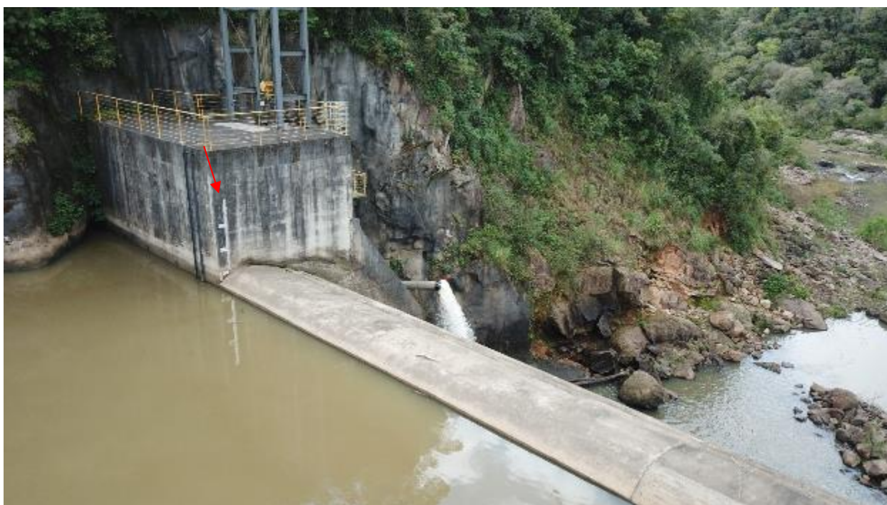
Figura 34 – Régua de montante e lateral da Barragem boas condições
