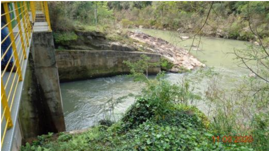
Figura 87 – Canal de fuga (Inp. 2020)
