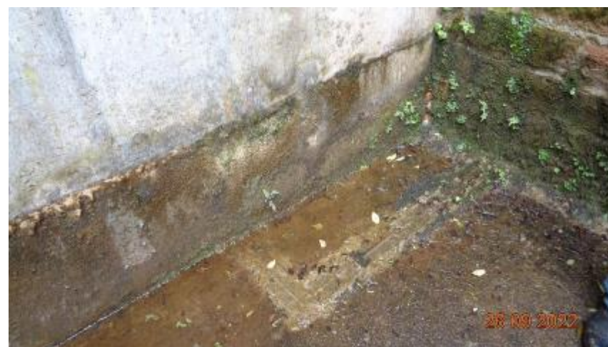
Figura 21 – Medidor de vazão ombreira esquerda, desativado por falta de água (Insp. 2022)
