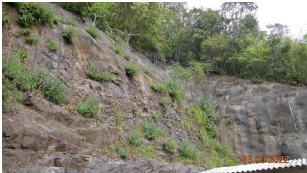
Figura 69 – Manter retirada vegetação do talude (Inspe. 2022)
