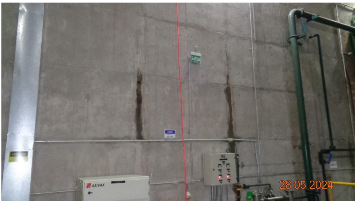
Figura 49 – Parede de montante em boas condições com pequena infiltração
