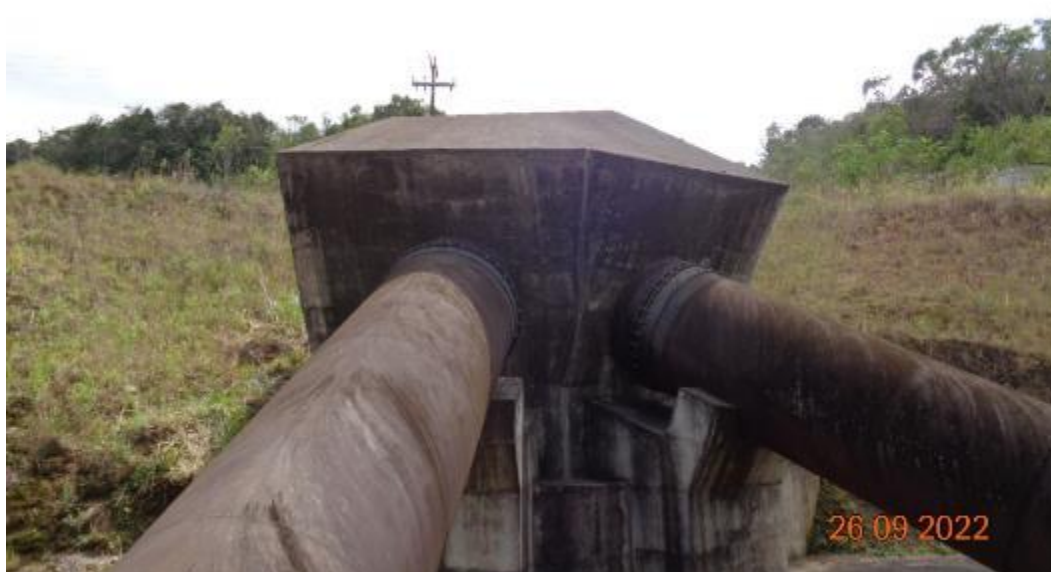
Figura 81 – Bloco Ancoragem da bifurcação na chegada da Casa de Força
