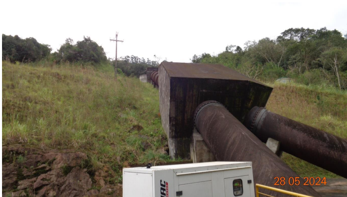
Figura 43 – Bloco Ancoragem da bifurcação na chegada da Casa de Força
