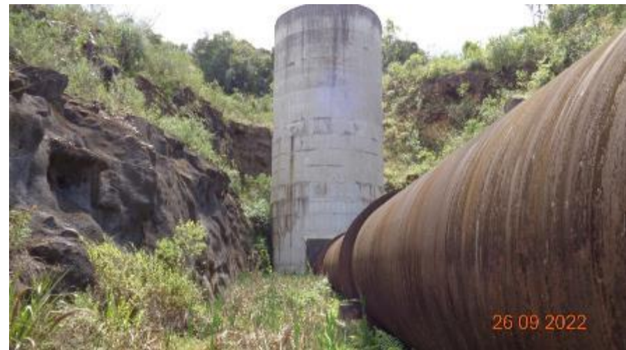
Figura 74 – Chaminé de Equilíbrio vedada infiltrações com injeções (Insp. 2022)
