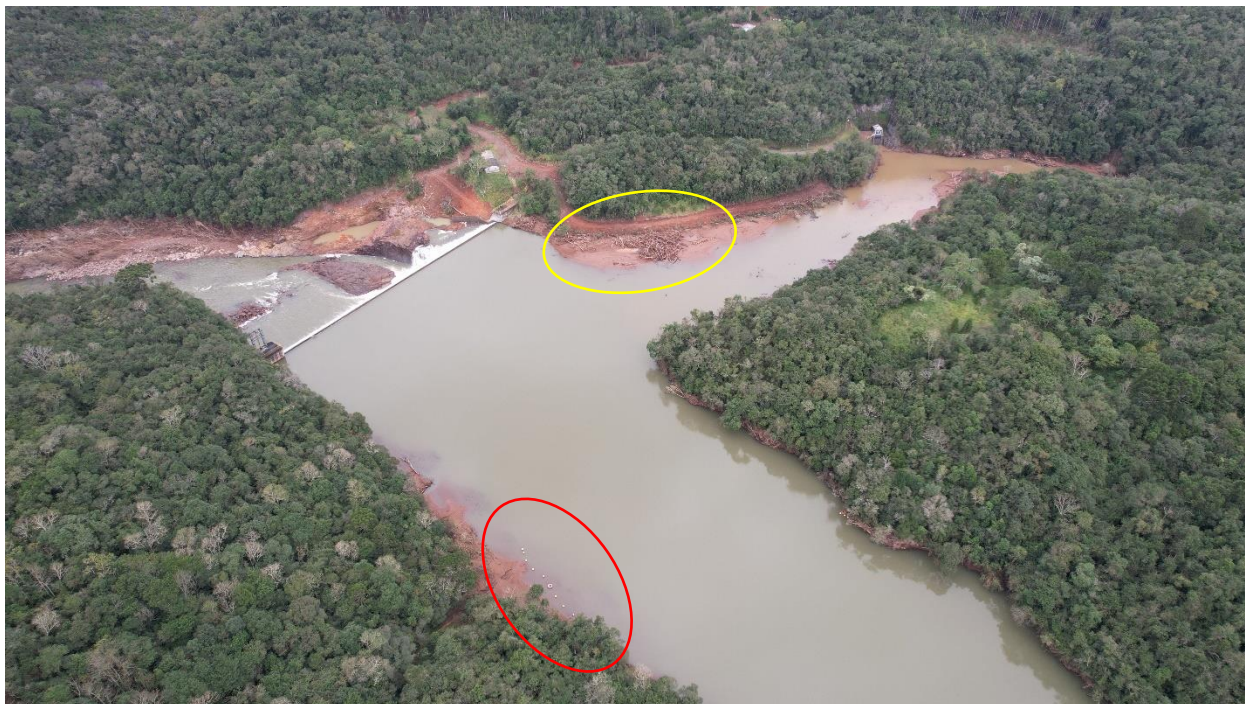
Figura 20 – Boias sinalizadoras do reservatório e depósito de materiais das cheias (amarelo)
