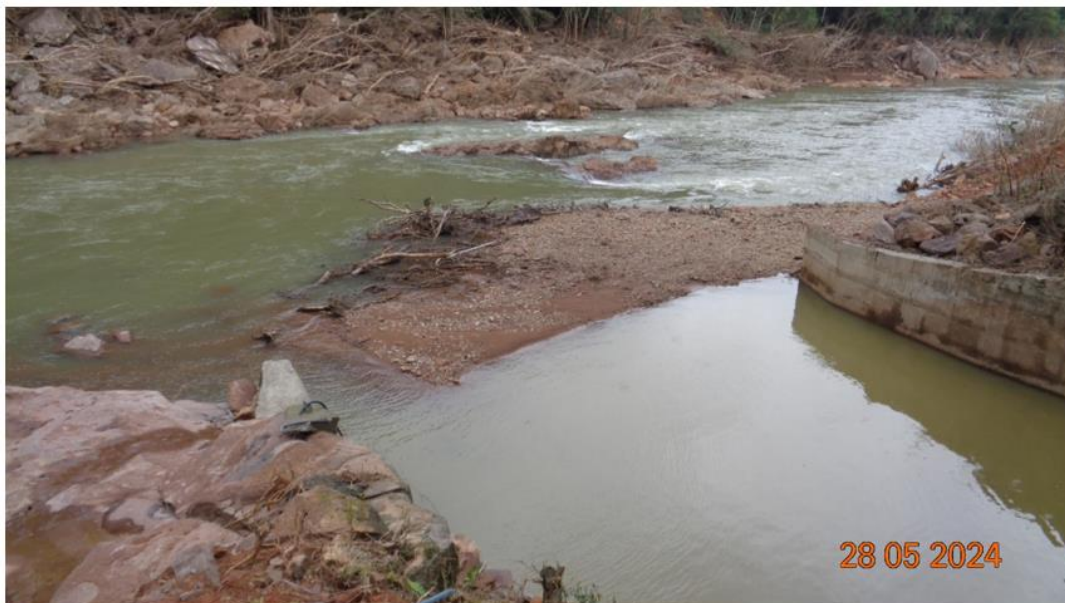
Figura 56 – Barra de material depositado na jusante do canal de fuga
