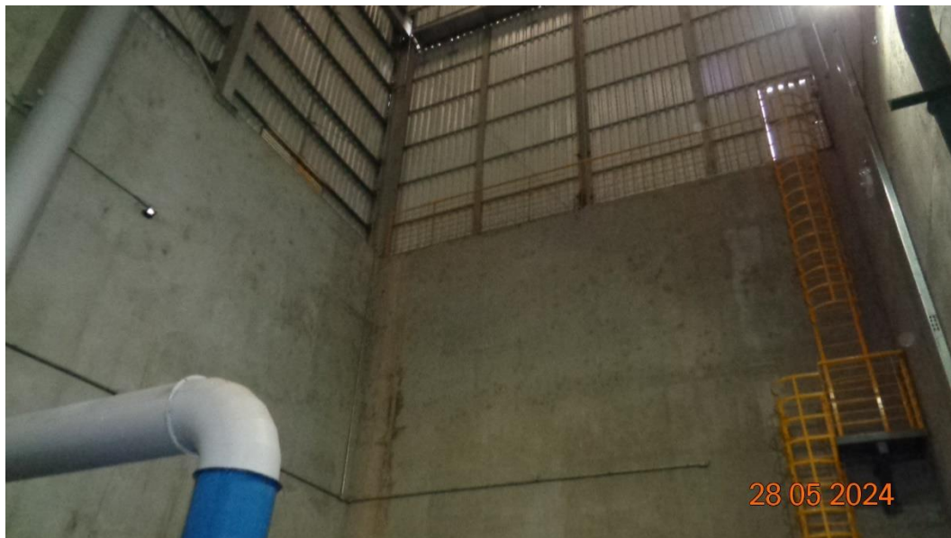
Figura 51 – Parede lateral direita sem infiltrações
