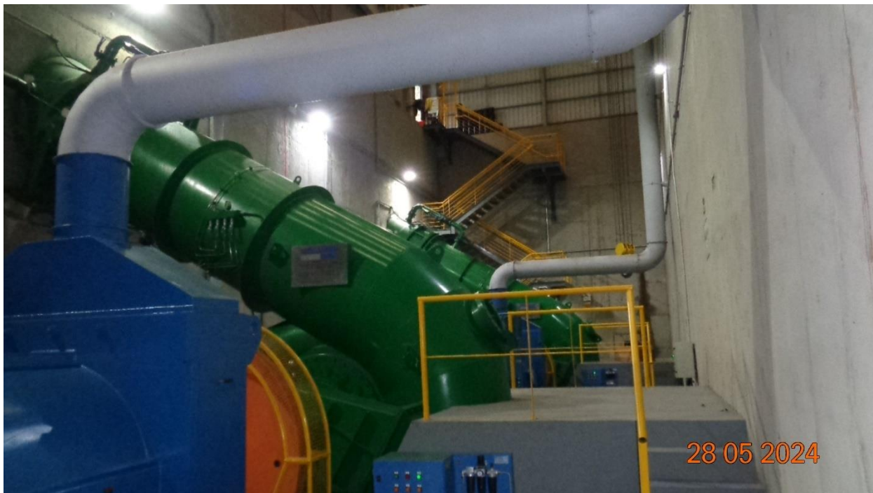
Figura 48 – Vista geral interna com escada de acesso ao fundo
