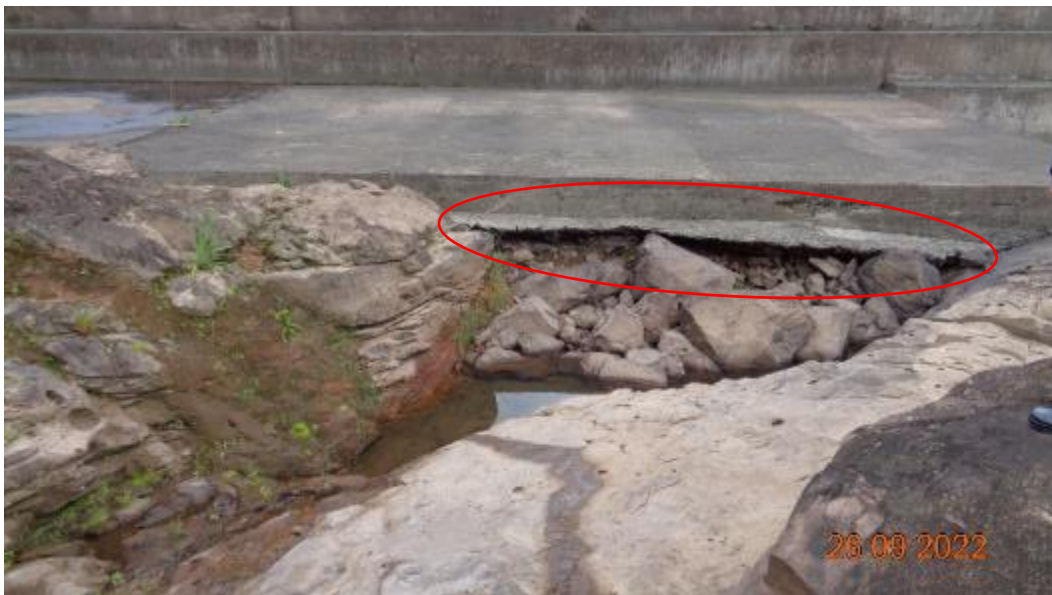
Figura 52 – Realizar concreto dental para dar laje de concreto
