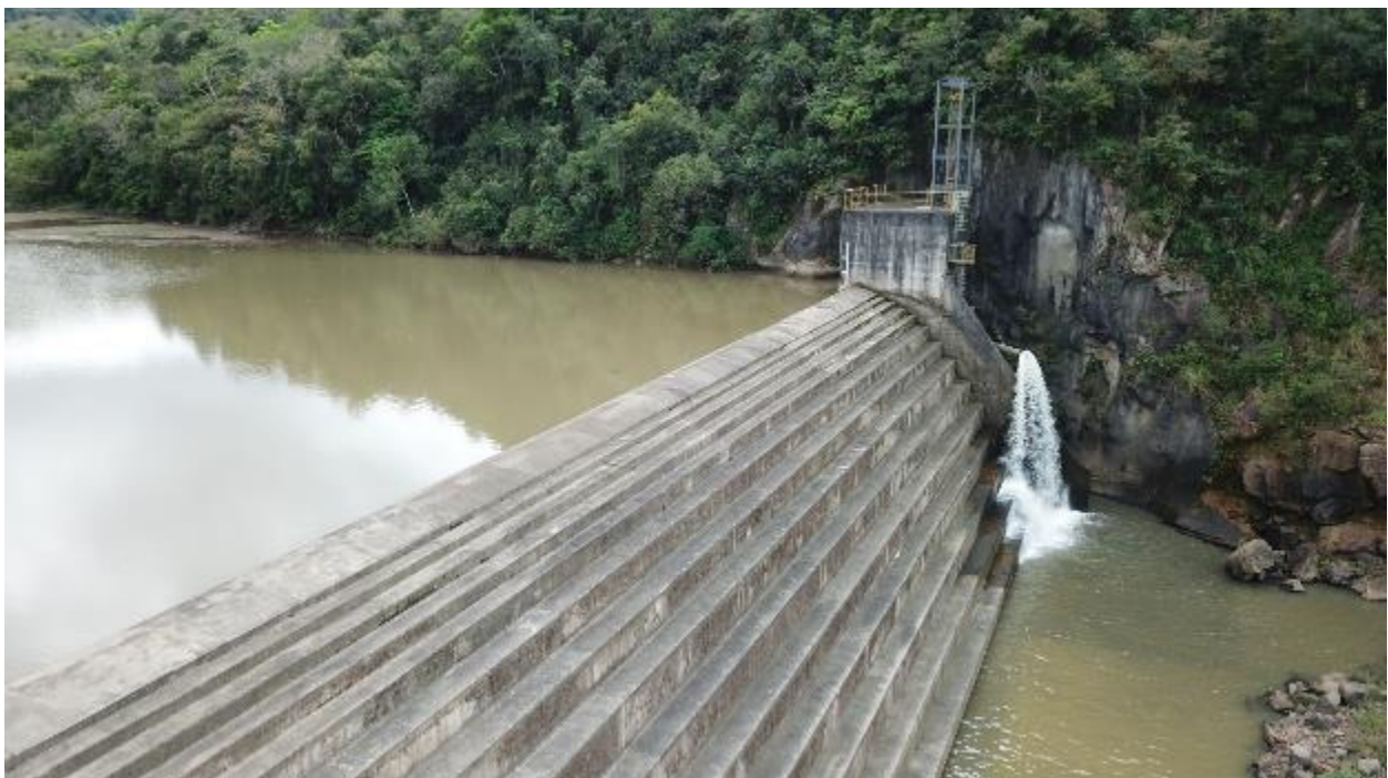
Figura 45 – Soleira do vertedouro
