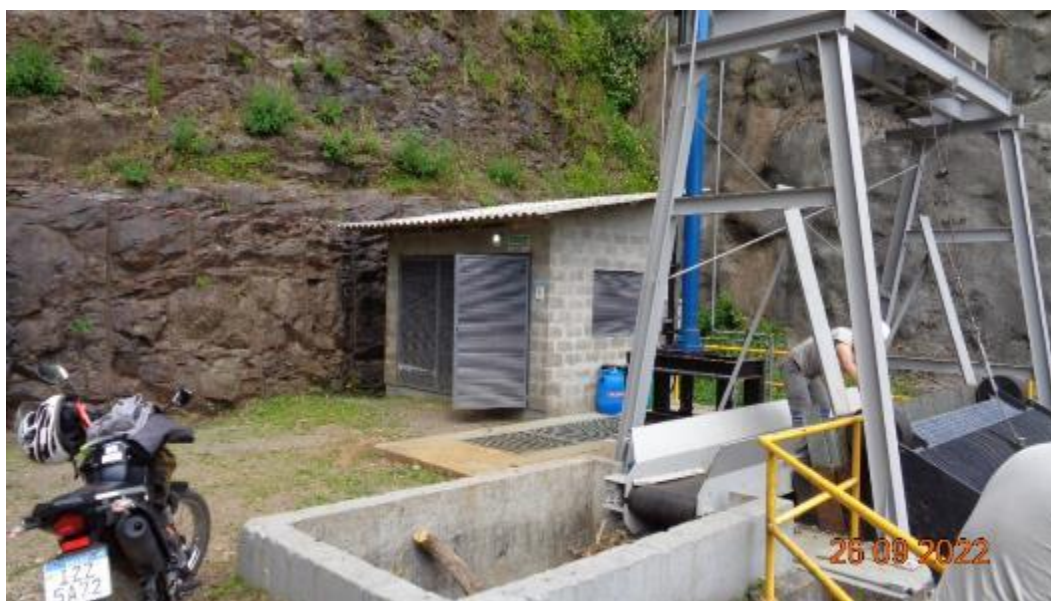
Figura 64 – Montante da tomada de água, com limpa grades
