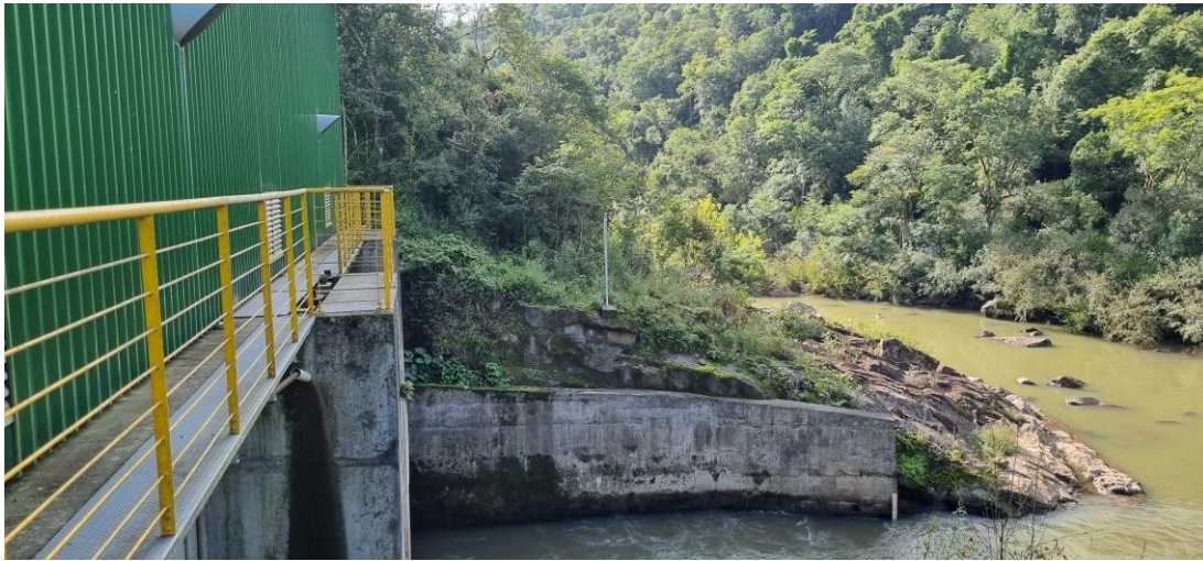
Figura 5 – Canal de fuga
