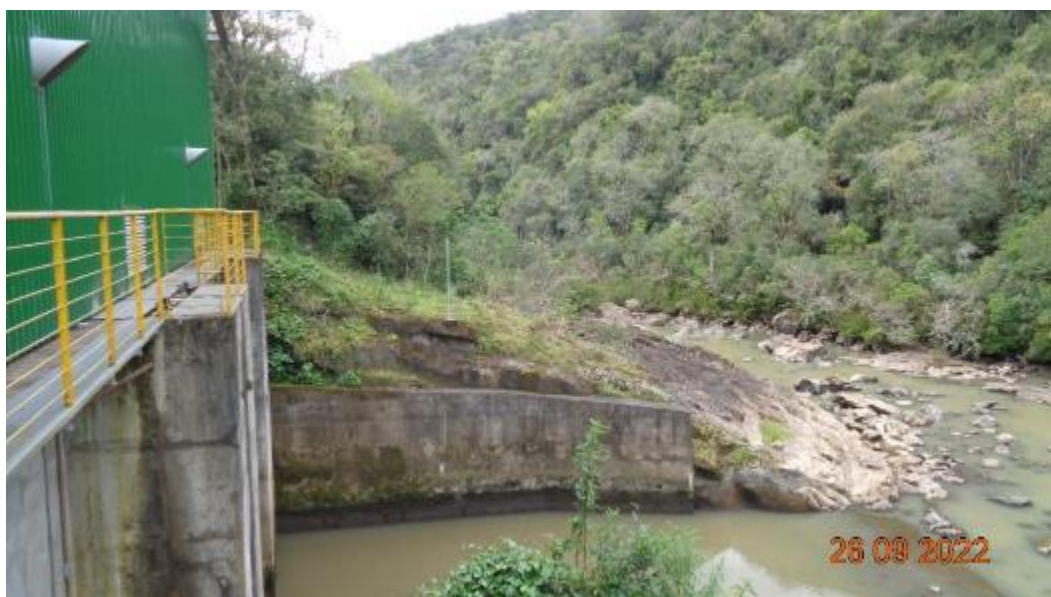
Figura 88 – Canal de fuga (Inp. 2022)
