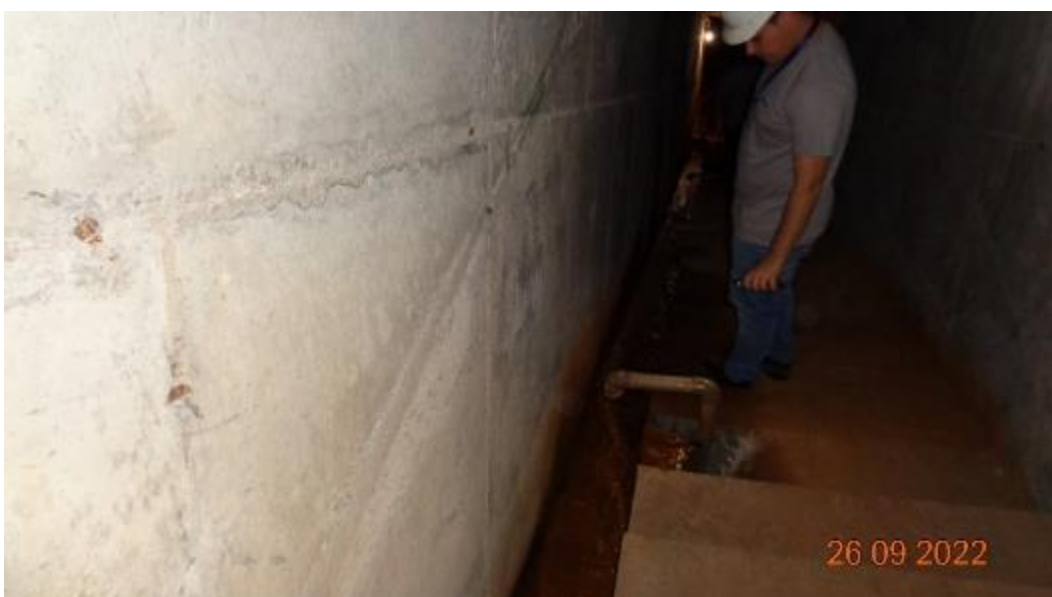
Figura 57 – Galeria de drenagem
