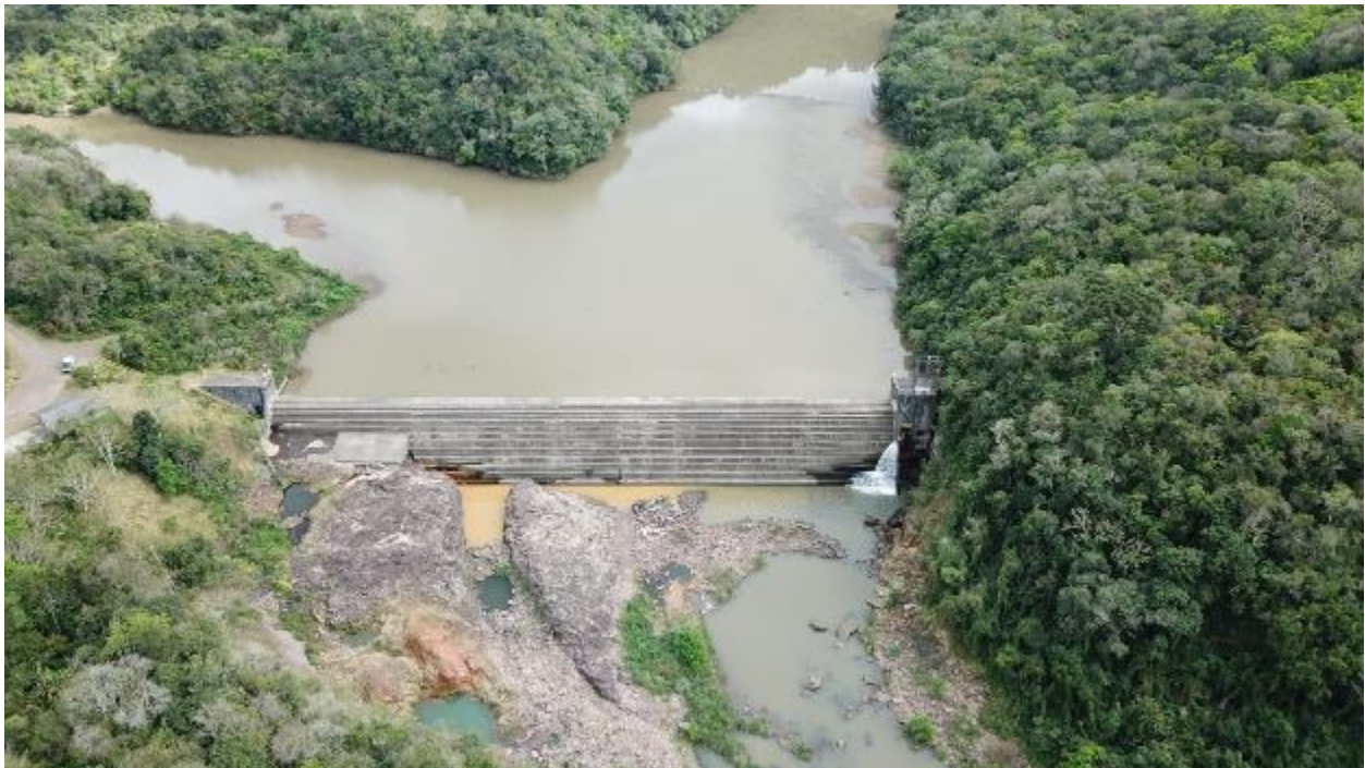
Figura 44 – Vista geral do Vertedouro
