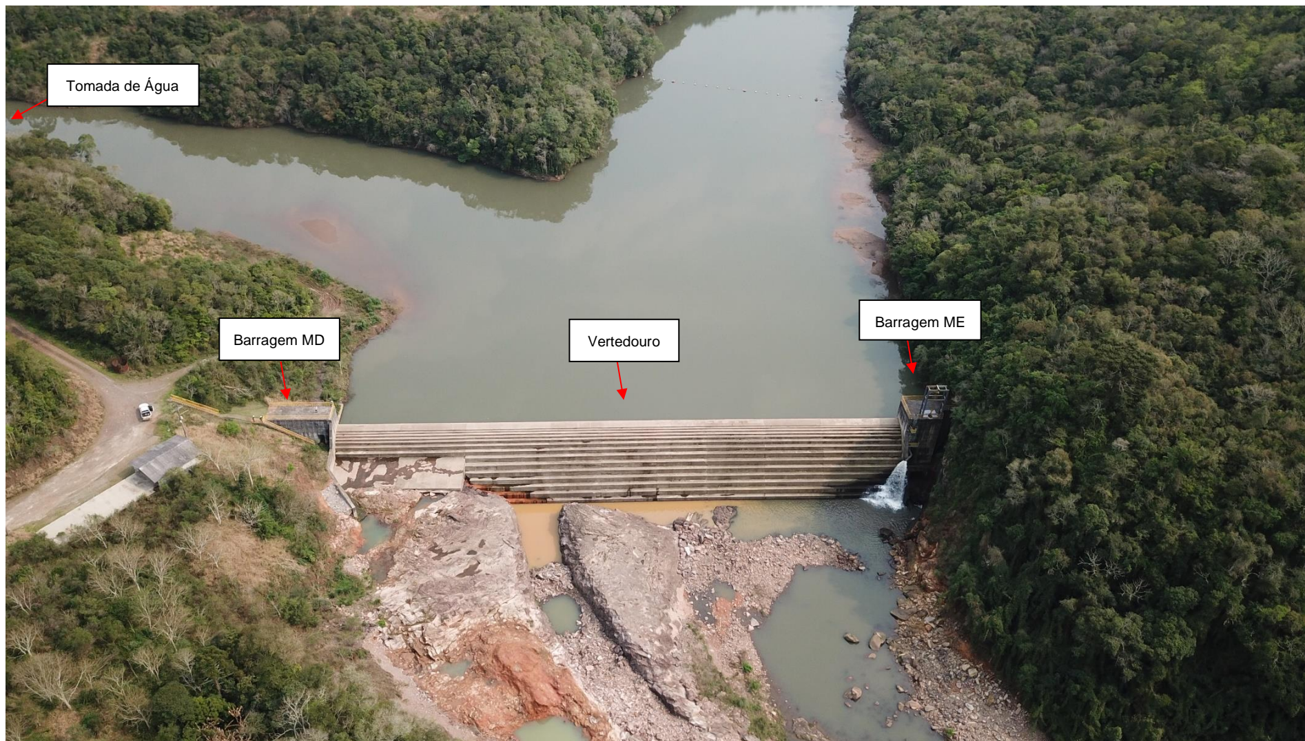
Figura 1 – Estruturas do Barramento da PCH RASTRO DE AUTO
