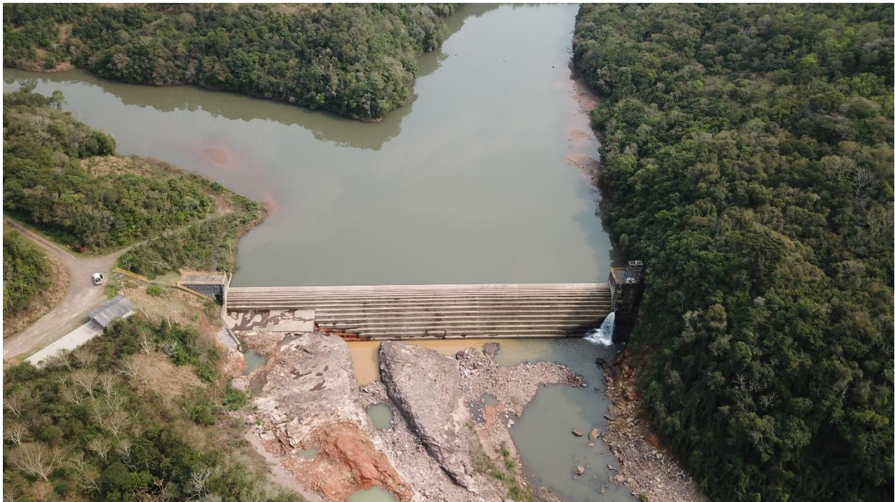
Figura 17 – Vista Geral do Barramento
