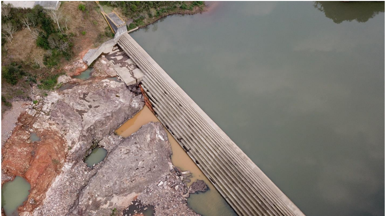
Figura 8 – Vertedouro da PCH Rastro de Auto
