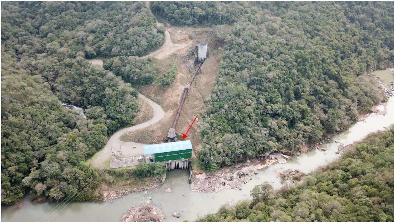
Figura 28 – Casa de Força da PCH Rastro de Auto
